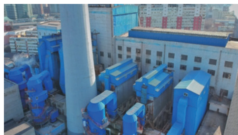
图：超低排放工程改造后全面
